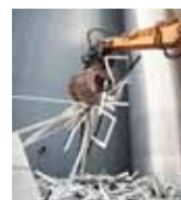
Collecte des anciennes menuiseries PVC
