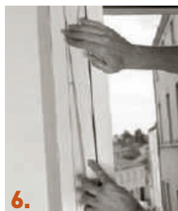
6. Réalisation des habillages intérieurs et extérieurs pour garantir une qualité de finition optimale.
