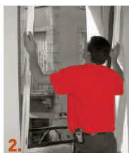
2. Mise en place de la nouvelle menuiserie.
