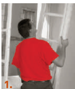
1. Dégondage des ouvrants.
